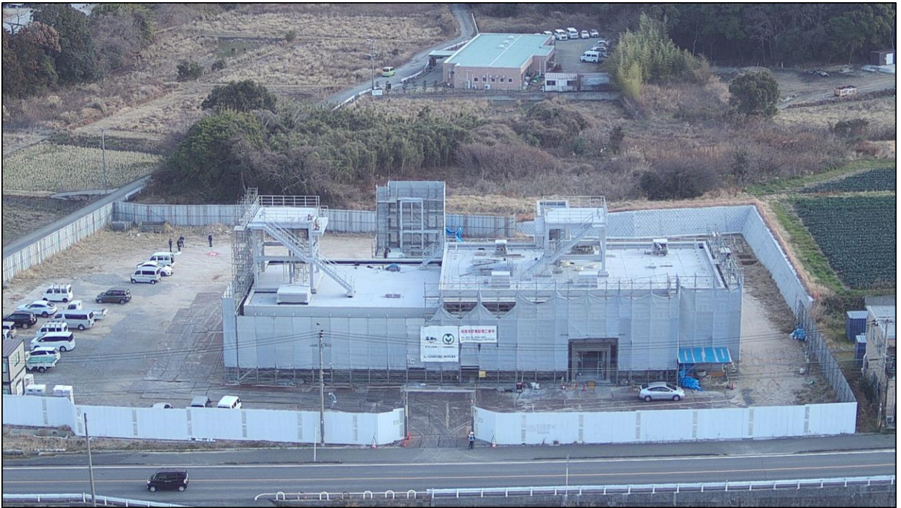
建築工事着工 No.9 令和7年1月16日撮影
